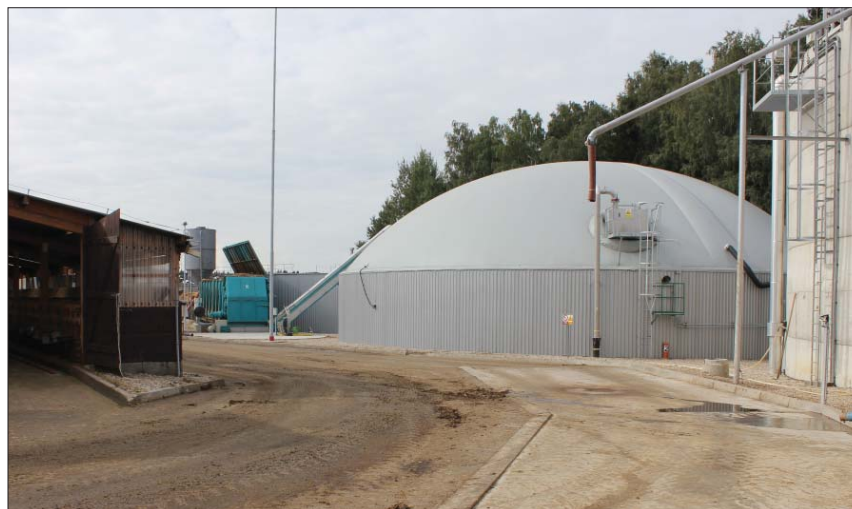
Bioplynová stanice v areálu farmy funguje již rok, odpadní teplo se využívá v dojírně a k vytápění administrativní budovy Foto Lukáš Rytina
